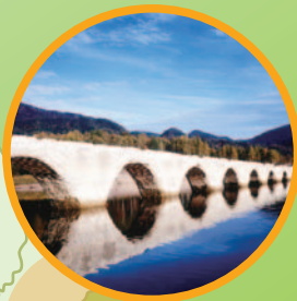
タウシュベツ川橋梁
